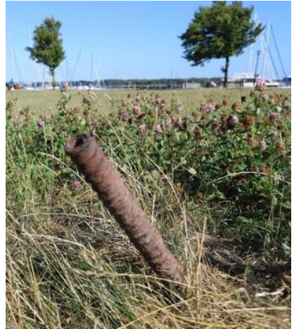
Abbildung 3: Alte Eisen vom Treppenbau sind potentielle Gefahrenquellen
